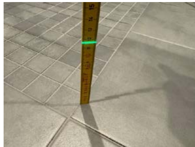
Fallforhold ca. 116 mm overkant gulv ved dusjsone
