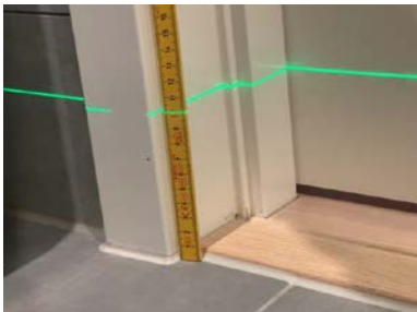
Fallforhold ca. 100 mm overkant gulv ved terskel
