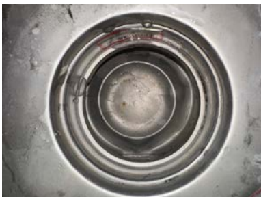
Stålsluk med vannlås i dusjsone
