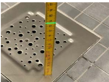
Fallforhold ca. 135 mm topp slukrist i dusjsone
