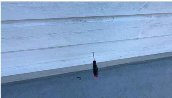
Stikk kontroll av vegger er utført.
