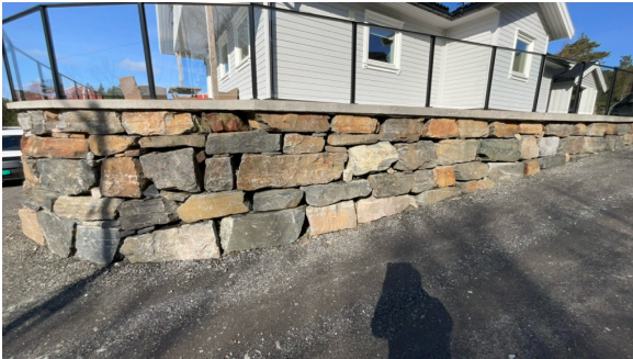
Del av forstøtningsmur.
