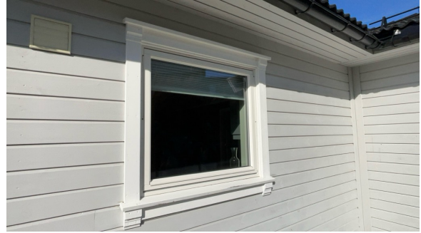
Eksempel på vindu i yttervegg.
