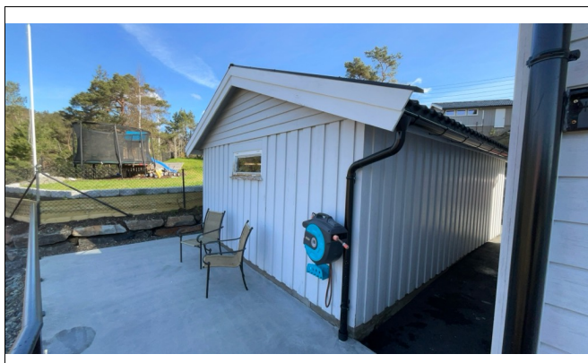
Garasje oppført på eiendommen.
