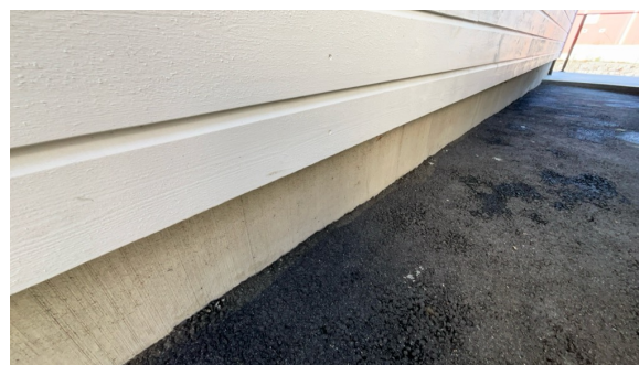
Del av grunnmur.
