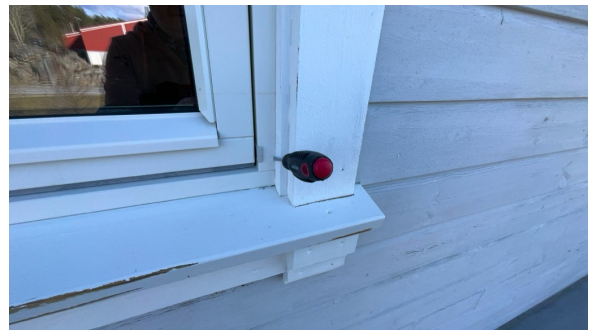
Stikk kontroll på vinduer er utført.
