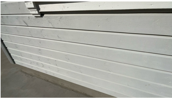
Del av vegg.
