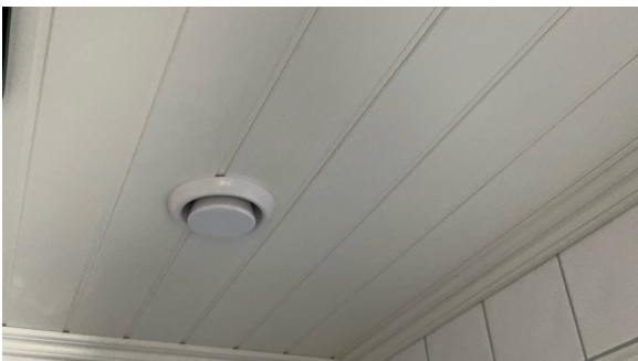
Montert avtrekk i tak.
