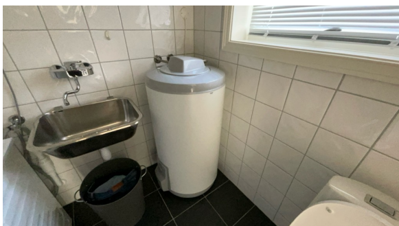
Varmtvannstank.
