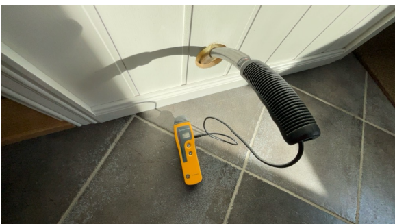
Hull for kontroll av fukt.
