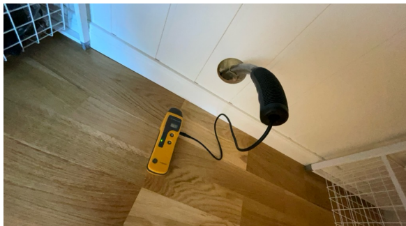
Hull for kontroll av fukt.
