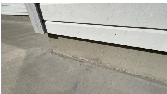
Del av grunnmur.
