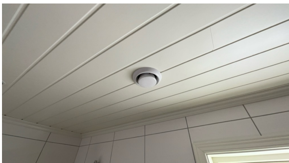
Montert avtrekk i tak.
