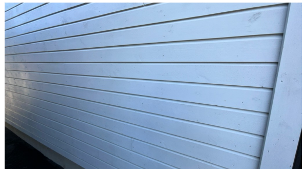
Del av vegg.
