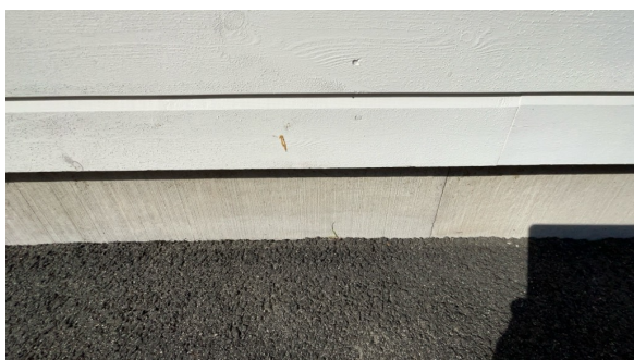
Del av grunnmur.
