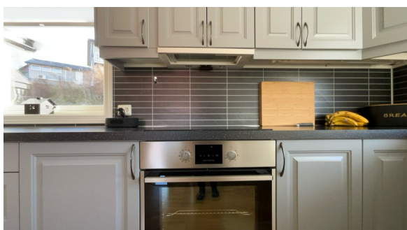
Montert avtrekk over steketopp.
