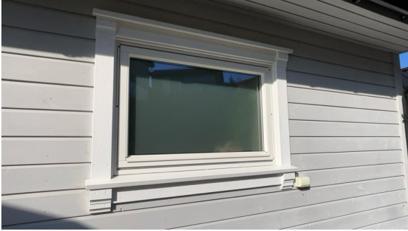
Eksempel på vindu i yttervegg.
