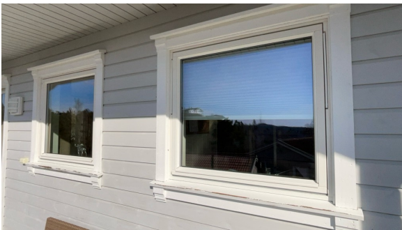
Eksempel på vindu i yttervegg.
