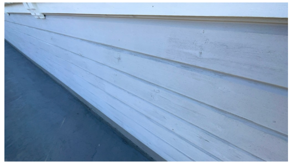
Del av vegg.
