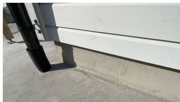
Del av grunnmur.
