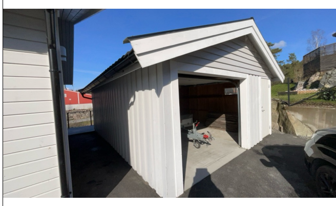
Garasje oppført på eiendommen.
