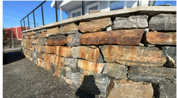
Del av forstøtningsmur.
