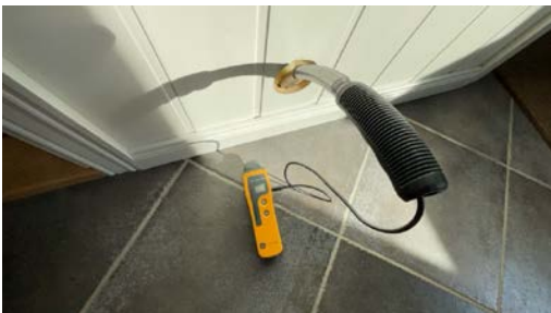
Hull for kontroll av fukt.
