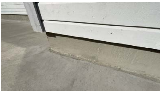
Del av grunnmur.
