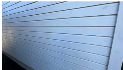
Del av vegg.
