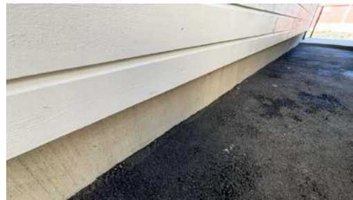
Del av grunnmur.
