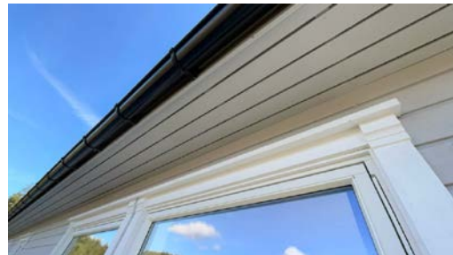
Del av gesims.
