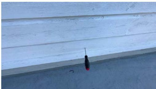
Stikk kontroll av vegger er utført.
