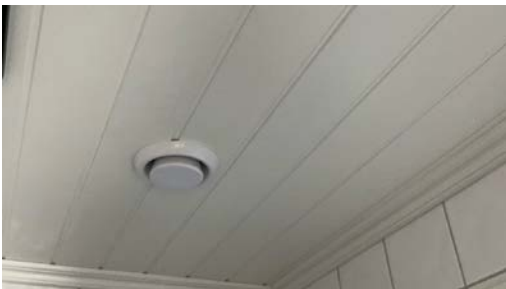
Montert avtrekk i tak.
