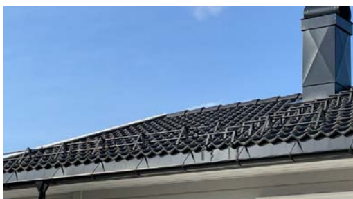
Del av taktekkning.
