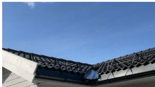
Del av taktekkning.
