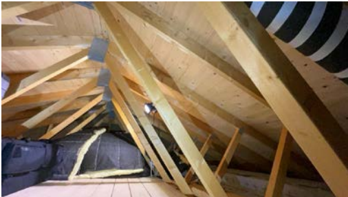
Del av takkonstruksjon, sett fra loft.
