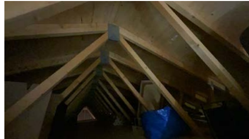
Del av takkonstruksjon, sett fra loft.
