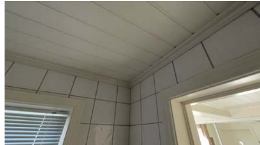
Del av vegg - tak.
