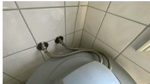
Del av rør til vann.
