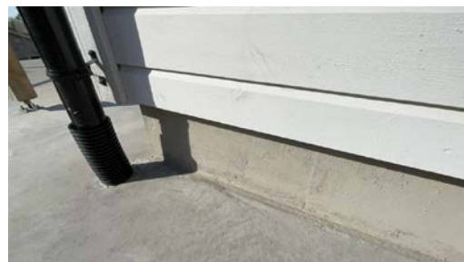
Del av grunnmur.
