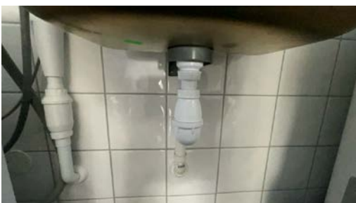
Del av rør til avløp.
