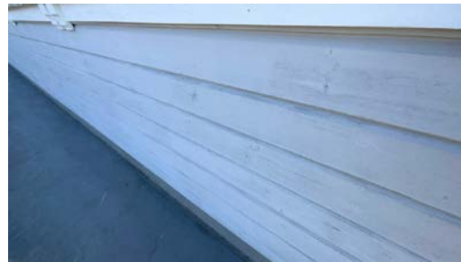
Del av vegg.
