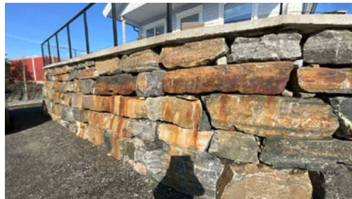
Del av forstøtningsmur.
