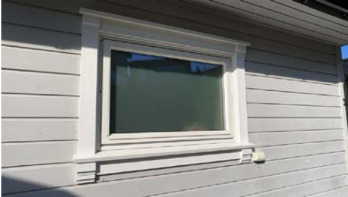
Eksempel på vindu i yttervegg.
