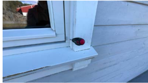
Stikkontroll på vinduer er utført.
