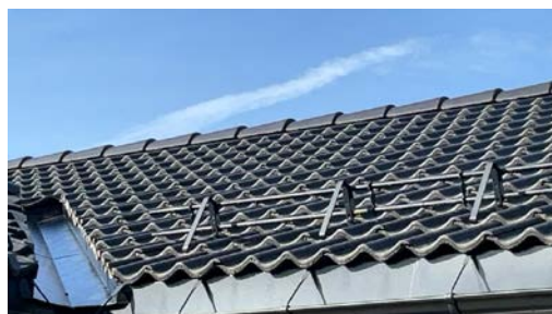
Del av taktekkning.
