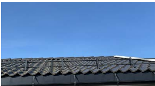
Del av taktekkning.
