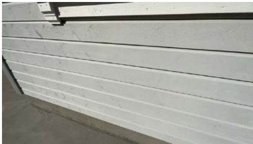
Del av vegg.
