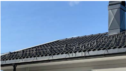
Del av taktekkning.
