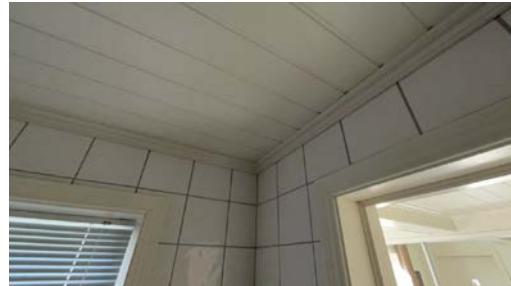
Del av vegg - tak.
