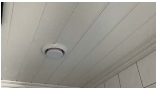
Montert avtrekk i tak.
