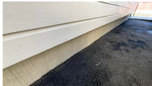
Del av grunnmur.
