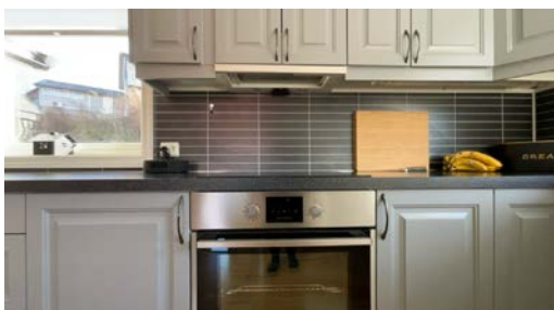
Montert avtrekk over steketopp.
