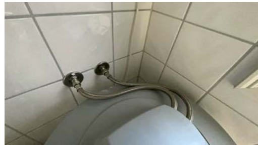
Del av rør til vann.
