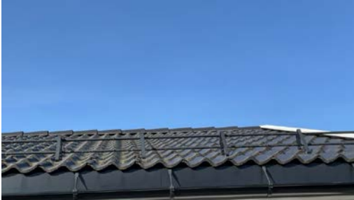
Del av taktekkning.
