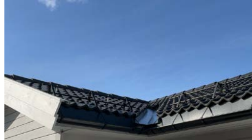
Del av taktekkning.
