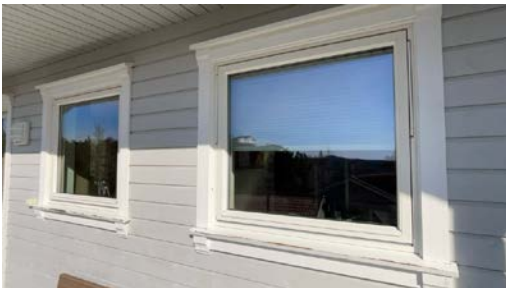
Eksempel på vindu i yttervegg.
