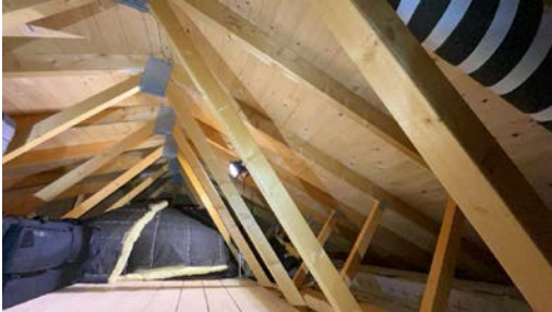
Del av takkonstruksjon, sett fra loft.
