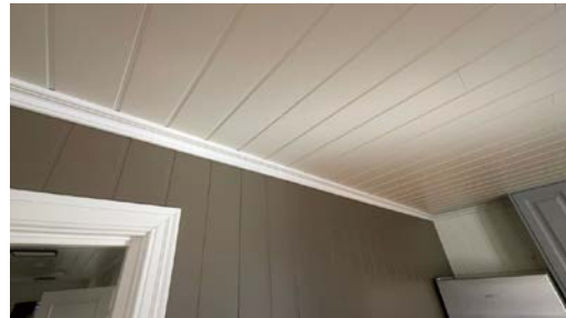
Del av vegg - tak.
