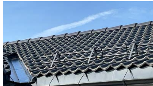
Del av taktekkning.
