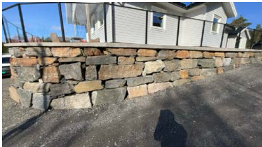
Del av forstøtningsmur.
