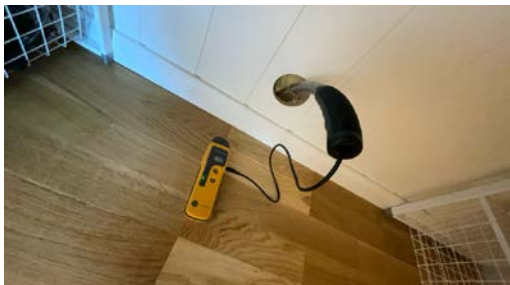
Hull for kontroll av fukt.
