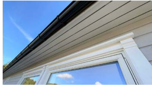
Del av gesims.
