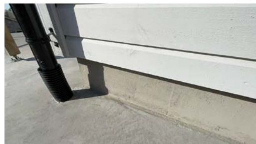
Del av grunnmur.
