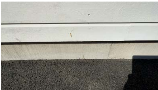
Del av grunnmur.
