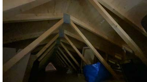
Del av takkonstruksjon, sett fra loft.
