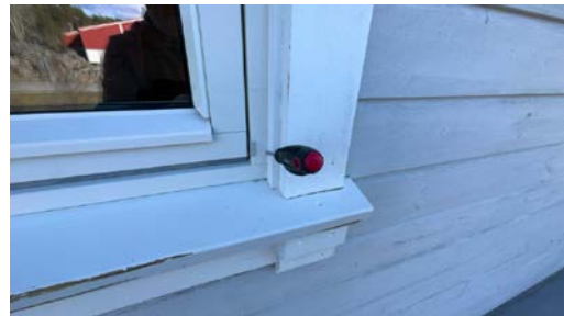
Stikkontroll på vinduer er utført.
