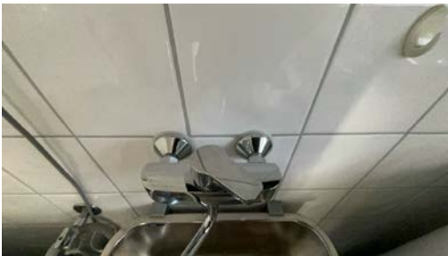
Del av rør til vann.
