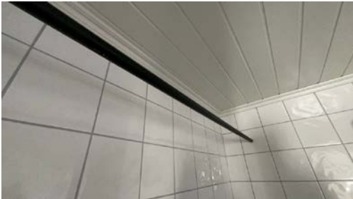
Del av vegg - tak.
