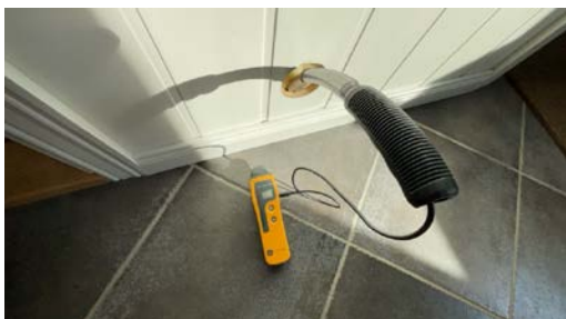
Hull for kontroll av fukt.
