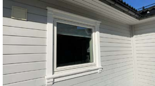
Eksempel på vindu i yttervegg.
