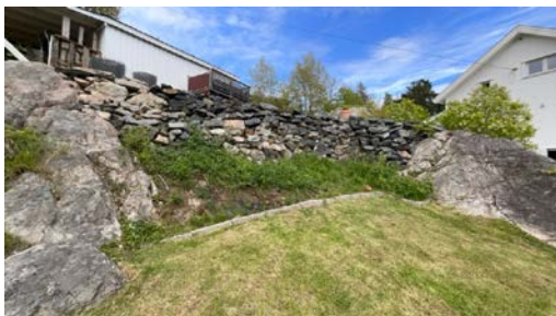
Forstøtningsmur i naturstein.
