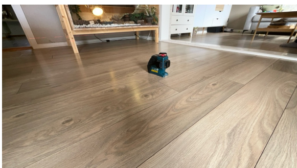
Høydeforskjeller kontrollert.
