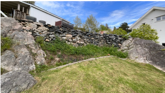
Forstøtningsmur i naturstein.
