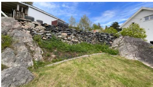
Forstøtningmur i naturstein.
