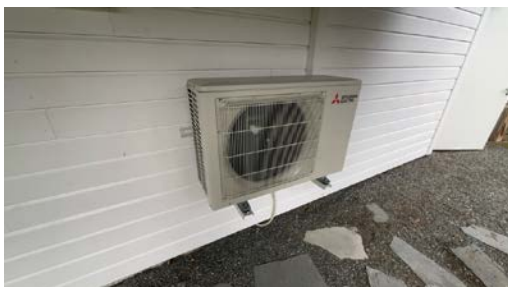
Varmepumpe, utvendig aggregat.
