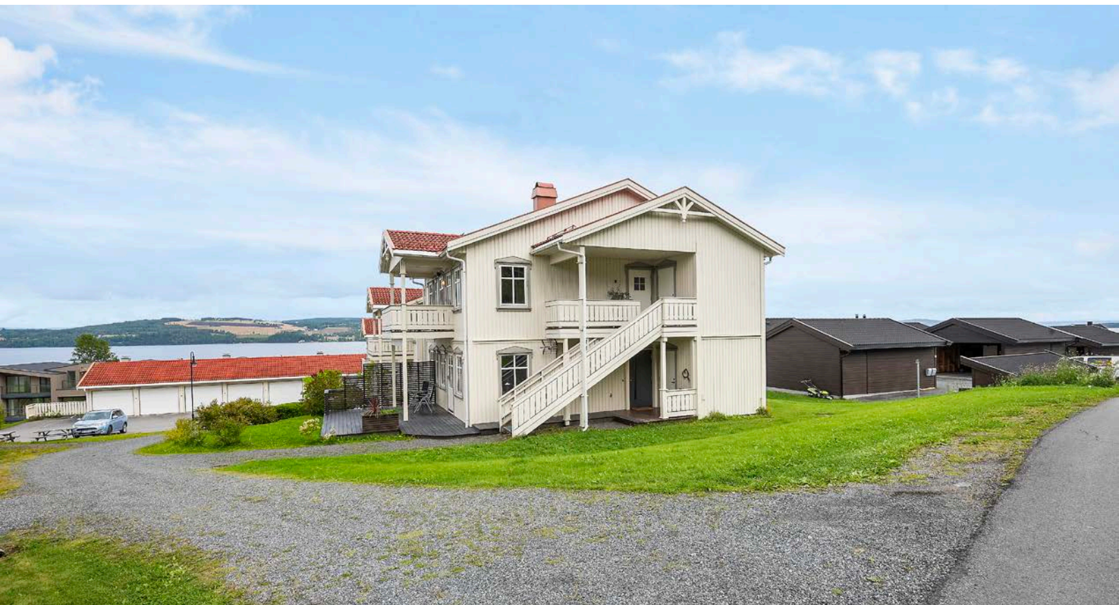
Tomt med plen rundt bygningen. Gruset adkomst.
