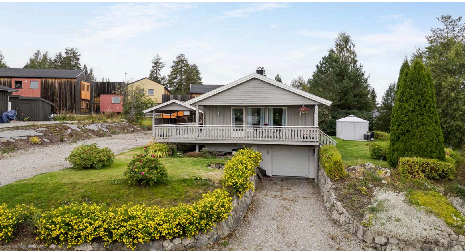
Gravd ut masser i kjeller og bygget garasjerom i 1986. Garasjen har støpt gulv i 2023, leddport med motorstyring, lys og strøm.
