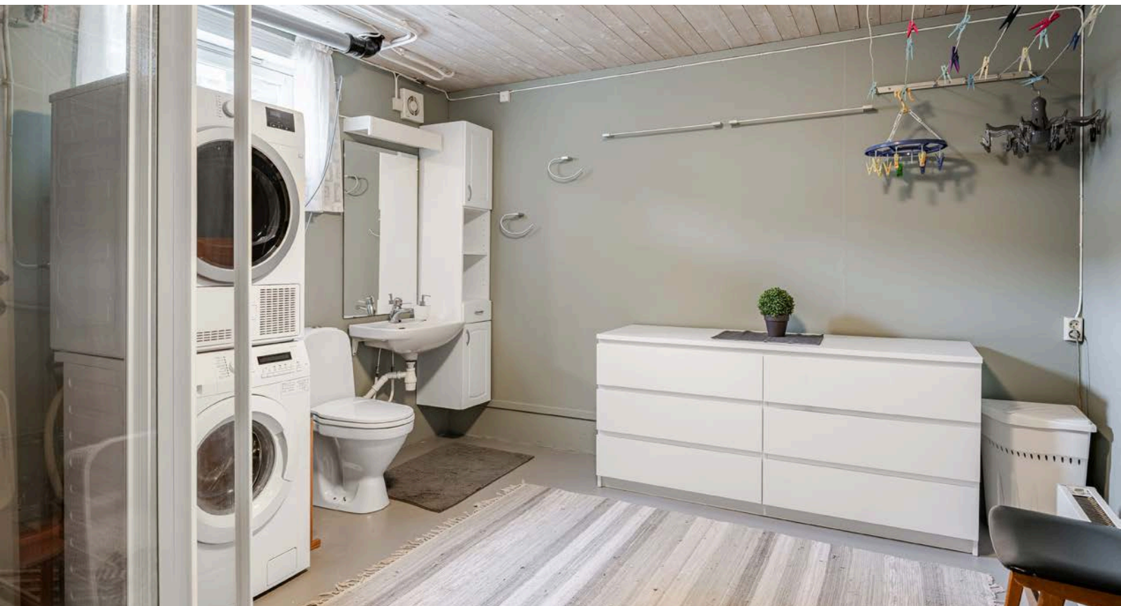
Bad/vaskerom i kjeller med overflater, installasjoner og komponenter fra 2009. Rommet har støpt gulv malt med våtromsmaling i 2024, vegger malt med våtromsmaling i 2024 og elektrisk styrt vifte.
