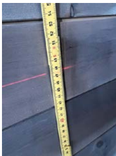
Ved kontroll av overflateplanhet ble laser benyttet, målt høyde på 47,5 cm som middelhøyde
