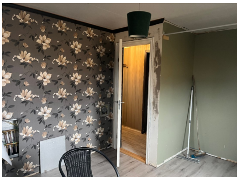
Flere rom er ikke ferdigstilt.
