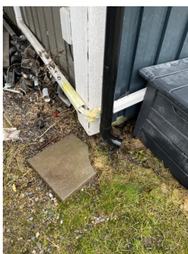
Nedløp er ikke ført vekk fra bygning.
