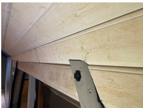
Det er benyttet utvendig kledning i loftetasje.
