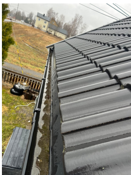
Nedløp er ikke ført vekk fra bygning.
