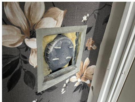
Stakeluke i soveromsvegg.
