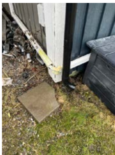
Nedløp er ikke ført vekk fra bygning.
