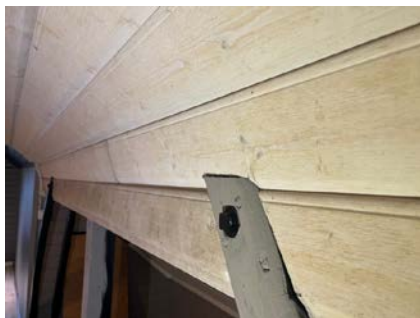
Det er benyttet utvendig kledning i loftetasje.
