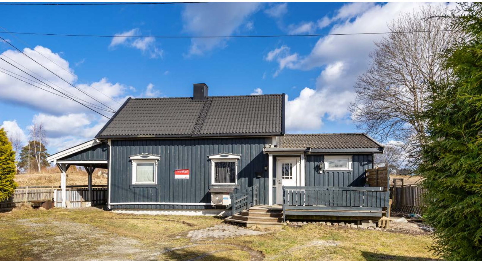
Eiendommen ligger landlig og barnevennlig til på Magnor. Tomten er flat, inngjerdet og opparbeidet med gressplen, prydbusker og steinbelagte områder.
