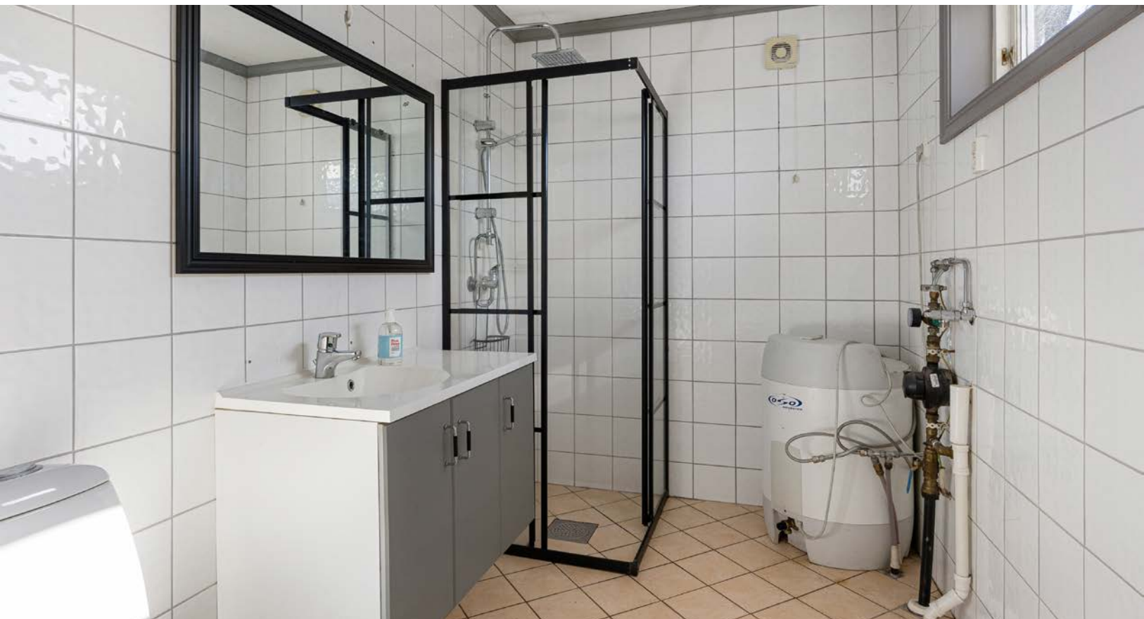
I 2022 ble det montert nye dusjvegger i et dusjhjørne med regnfallsdusj. Videre har badet et toalett, mekanisk avtrekk og opplegg for vaskemaskin.
