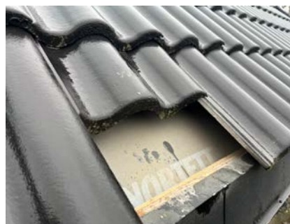
Taktekking av stein og undertaksplater på hoveddel.
