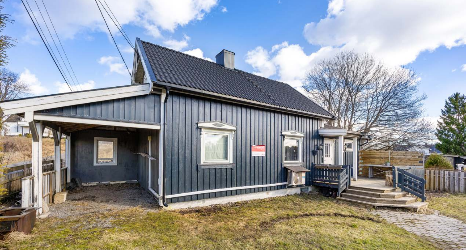
Det er parkering i en tilliggende carport fra 2013 samt på egen gårdsplass.
