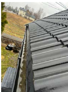
Nedløp er ikke ført vekk fra bygning.
