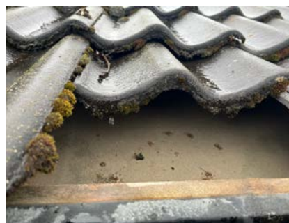
Taktekking av stein og undertaksplater på tilbygg.
