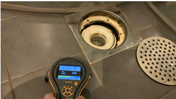
Ved bruk av fuktindikator ble det ikke registrert unormale fuktverdier på tilgjengelige overflater.
