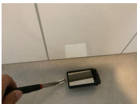
Våtromsplater uten bunnlist. Løse våtromsplater.
