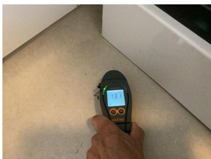
Ved enkle fuktsøk registrerte jeg ingen unormale verdier.
