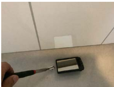
Våtromsplater uten bunnlist. Løse våtromsplater.
