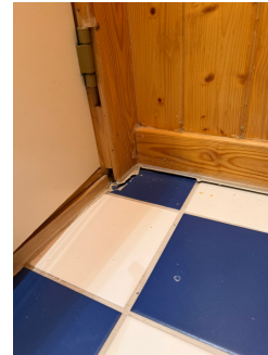
Oppsprekking og usikker overgang membran gulv/vegg.
