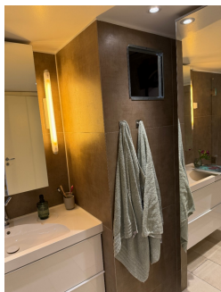
Innkassing med luke, til bereder.
