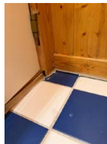
Oppsprekking og usikker overgang membran gulv/vegg.
