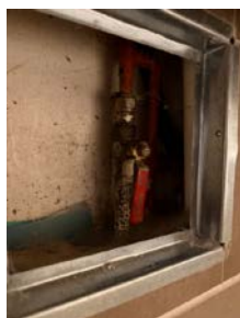
Stoppekran i bad i kjeller. Gamle vann-rør
