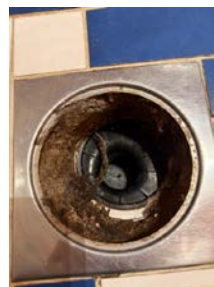
Oppsprekking og usikker overgang membran gulv/vegg.
