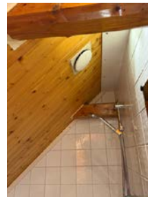
Takbjelke ført igjennom takoverflate/diffusjonssperre i våtsone.
