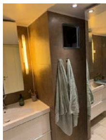
Innkassing med luke, til bereder.
