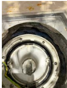
Hovedsluk plassert under badekar som er fuget fast.
