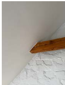
Takbjelke ført igjennom takoverflate/diffusjonssperre.
