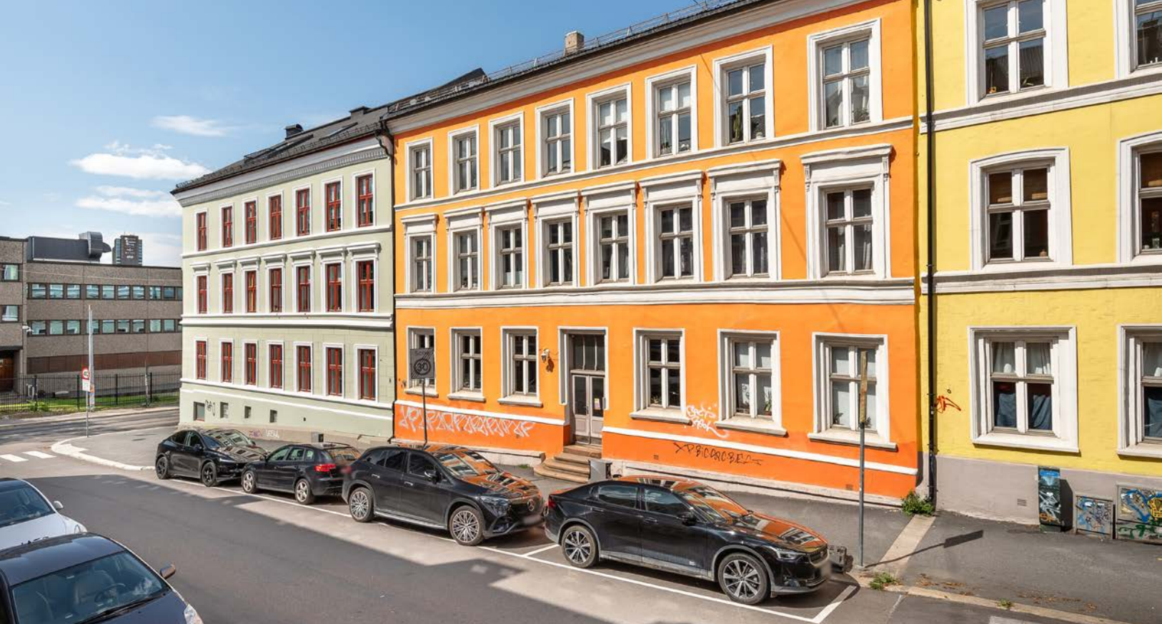
Arups gate 4 ligger i en fargerik og koselig gate.
