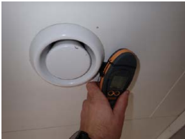
Ingen symptomer på fukt rundt ventil i tak på kjøkken.
