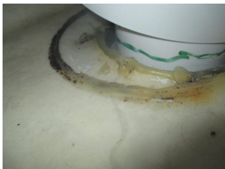
Er nå åpning i gulvet etter at nytt toalett ble montert
