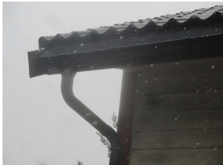
Nyere takrenner med tilhørende deler av stål.
