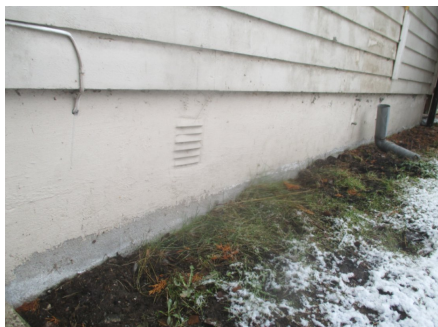
Deler av grunnmur.
