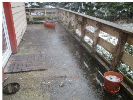
Veranda på enden av bygget.
