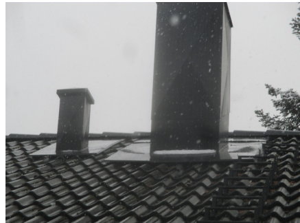
Pipe og luftehatt er helbeslått over tak
