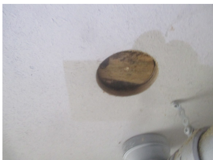
Hulltaking i himling på vaskerommet
