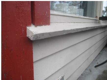
Deler av kledningen i hovedetasjen med tilhørende belistninger.
