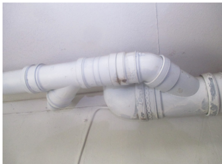
Plastrør i himling på vaskerommet
