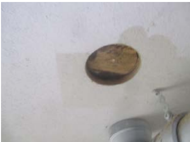
Hulltaking i himling på vaskerommet
