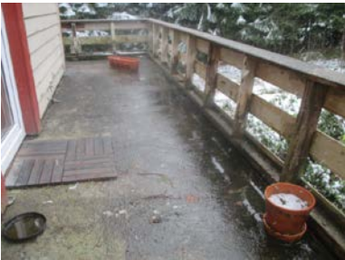
Veranda på enden av bygget.
