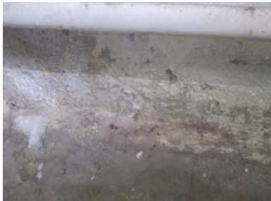
Noe fuktvandring ved søk i nedre del av grunnmur og direkte på støpte gulv.
