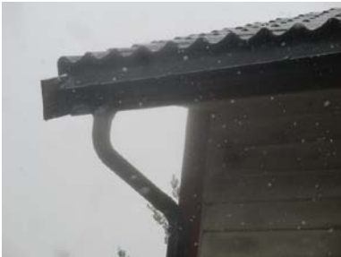
Nyere takrenner med tilhørende deler av stål.
