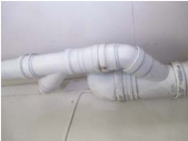
Plastrør i himling på vaskerommet
