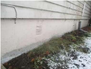
Deler av grunnmur.
