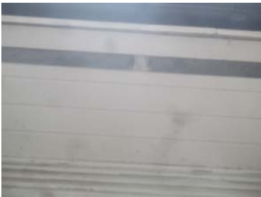
Luftespalter i gesimsen for tilgang på luft til kaldtloftet
