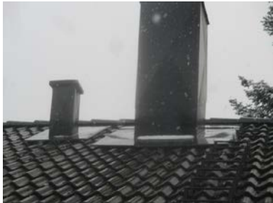
Pipe og luftehatt er helbeslått over tak
