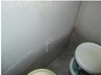
Noe fuktvandring ved søk i nedre del av grunnmur og direkte på støpte gulv.
