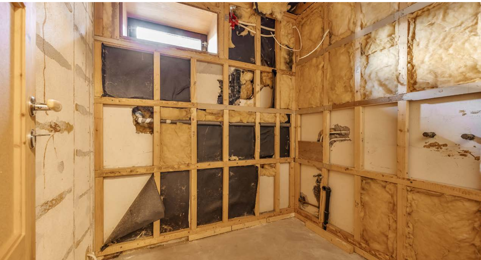
Ett rom i kjeller er tilrettelagt for våtrom.
