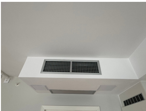
Viftekonvektor i stue/kjøkken.
