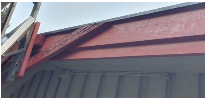
Råteskadet treverk
