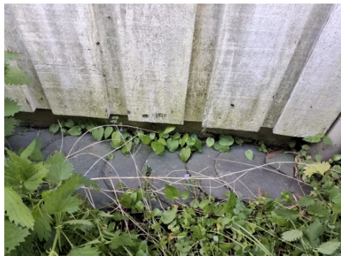
Kledningen er avsluttet nær bakken.
