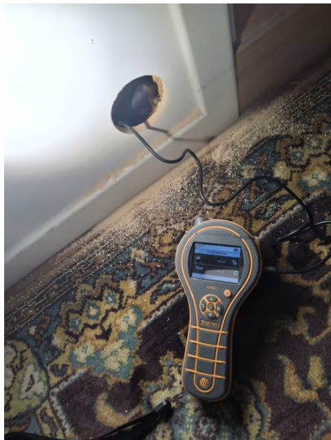
Bilde fra fuktmåling i veggkonstruksjon tilstøtende våtsone.
