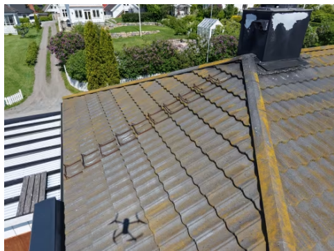
Det er etablert takstige til pipe.
