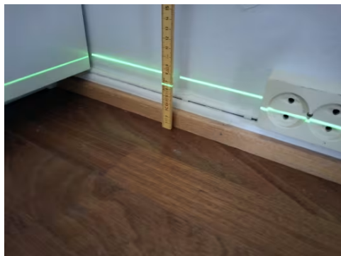
Etasjeskiller er kontrollert med nivelleringslaser.
