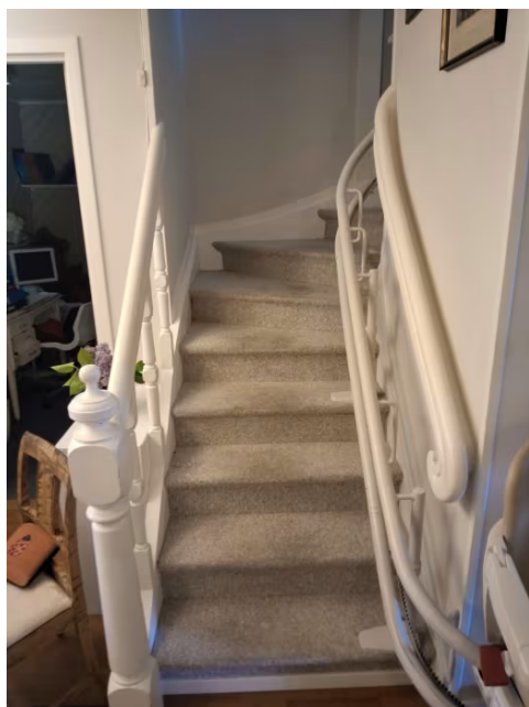
Trapp mellom første og andre etasje.
