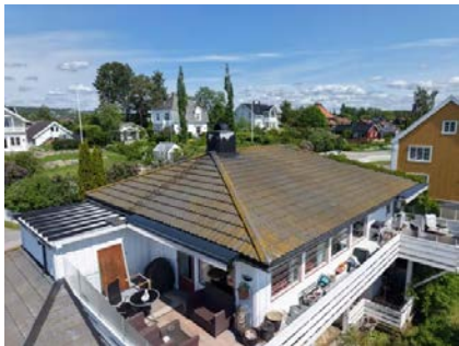
Vestvendt del av balkongen danner takkonstruksjon over deler av boligen.
