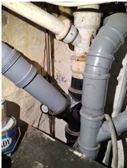
Boligen har synlige avløpsrør av plast og støpejern.
