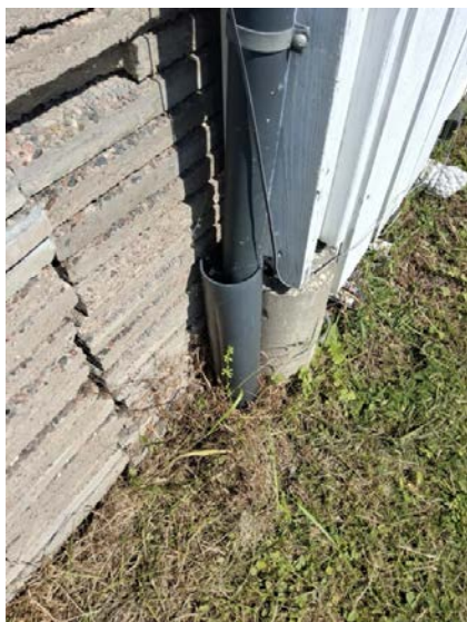
Taknedløp er avsluttet i rør ført ned i grunnen.
