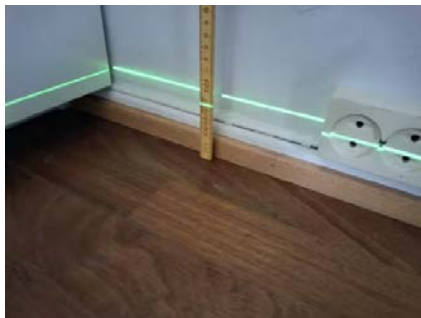
Etasjeskiller er kontrollert med nivelleringslaser.
