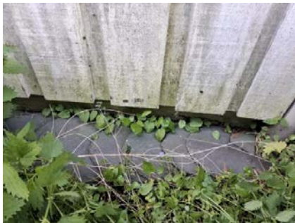
Grunnmur er lite tilgjengelig for undersøkelser.
