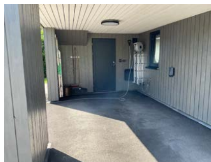
Carport med el-bil lader
