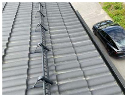
Snøfanger og takrenne
