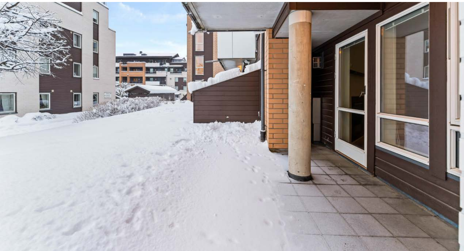
Markterrasse med steinheller og plass til utemøblement.
