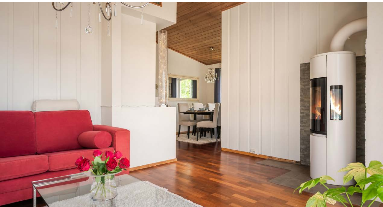
I stua er det både en pen peisovn og varmepumpe som sørger for lun og god varme hele året.
