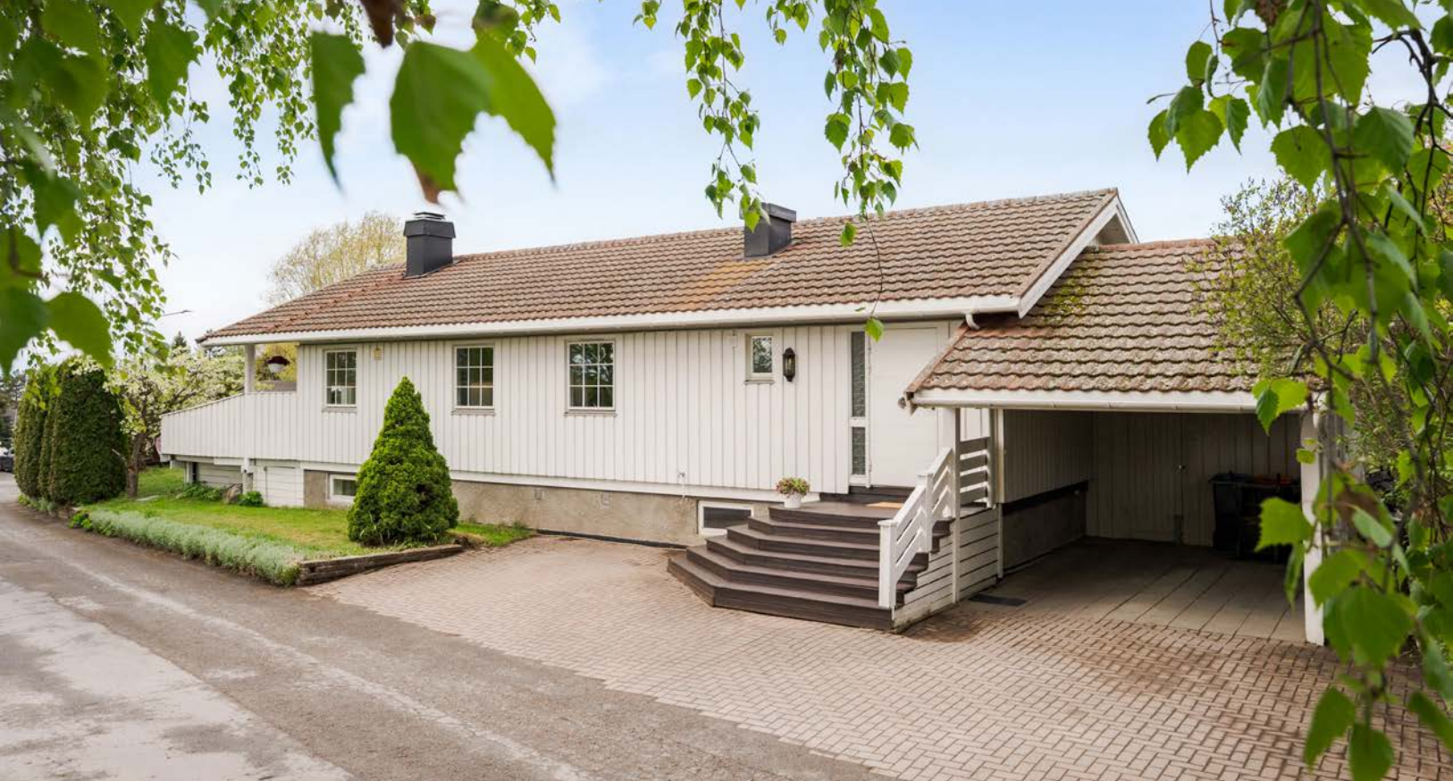
Pent opparbeidet gårdsplass med belegningsstein og adkomst til inntilbygget carport på ca. 19 m 2 .
