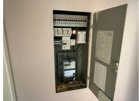
Bilde viser kontroll av el-skap på befaringssdagen.
