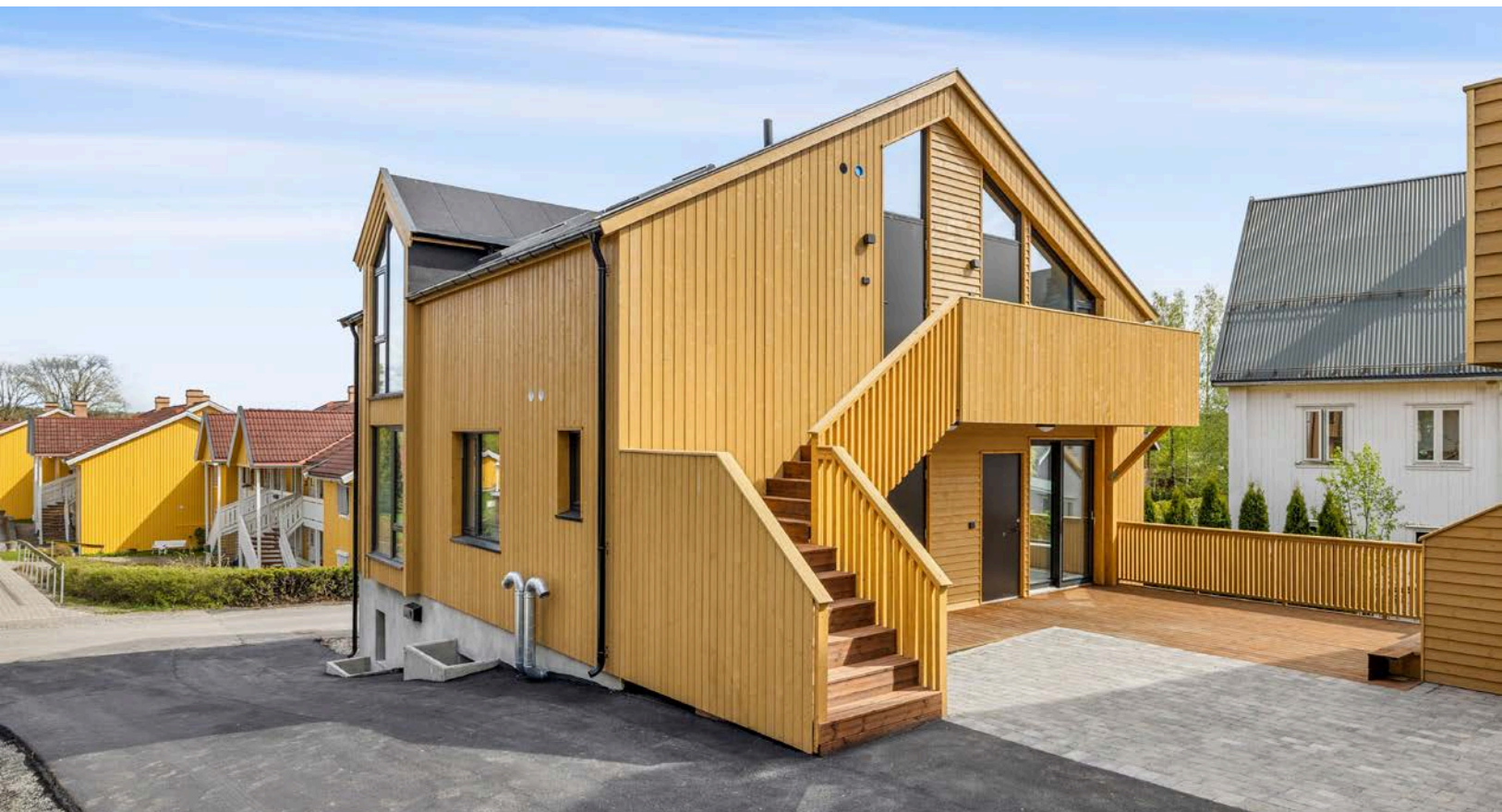
Seksjon nr. 3 og 4 har adkomst fra felles uteplass med terrasseplating og belegningsstein.
