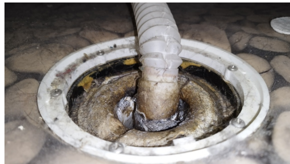
Kontroll av sluken.
