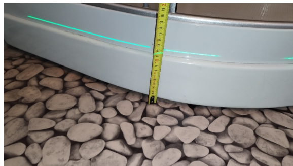
Kontroll av fall.
