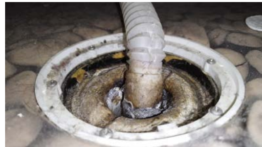
Kontroll av sluken.
