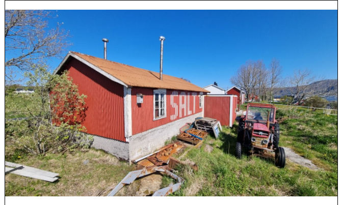
Baksiden av Polarsalt-bygget. Kan bygget bevares og ny bolig oppføres øst for dette (til høyre i bildet)?
