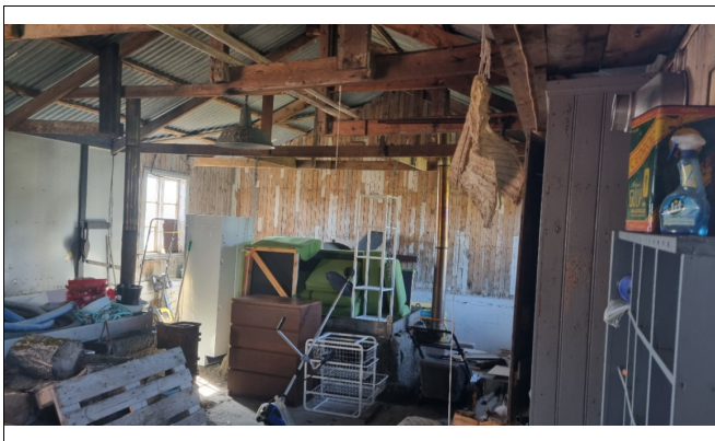
Innvendig bilde i bygget.
