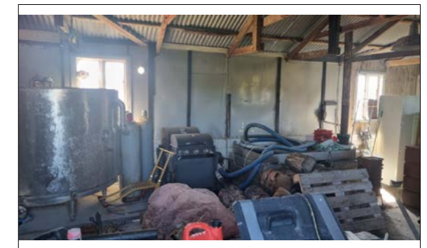
Bygget var låst ved befarings, men bilder ble tatt gjennom et knust vindu.
