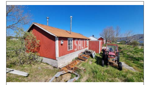
Baksiden av Polarsalt-bygget. Kan bygget bevares og ny bolig oppføres øst for dette (til høyre i bildet)?
