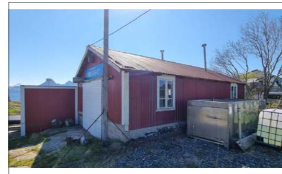
På vei inn i bygget...
