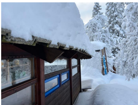
Skjevheter i takkonstruksjon
