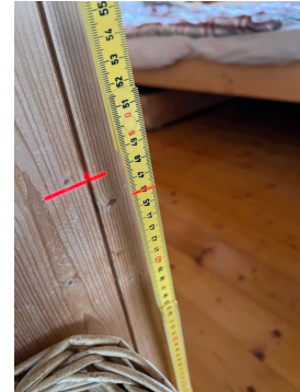
Ved plankontroll av gulv i enkelte rom ble det målt med laser høyde 46 cm
