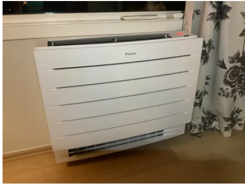
Luft/luft varmepumpe montert i stue 1. etg
