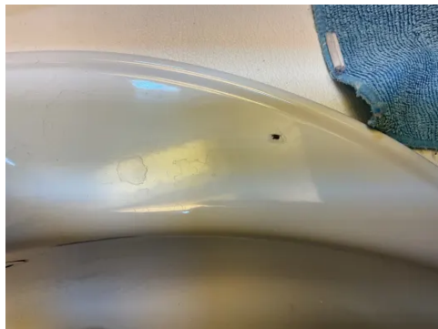
Sprekk i servant.
