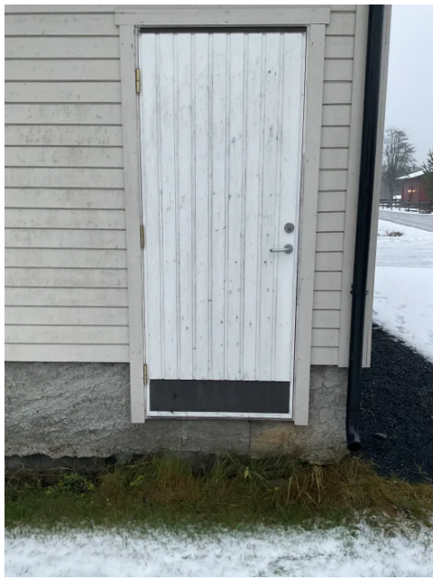
Boddør til garasje.
