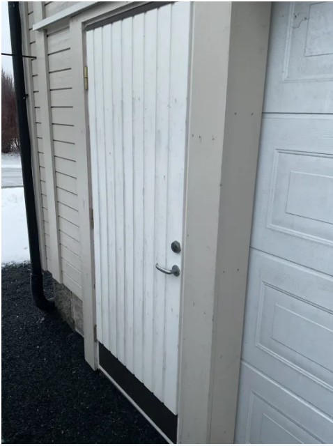
Boddør til garasje.
