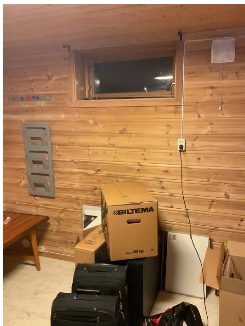
Vinduer i kjeller.
