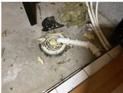
Sluket i teknisk rom.
