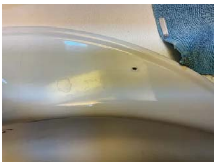
Sprekk i servant.
