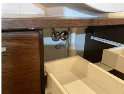
Avløpsrør bad 1. etg .
