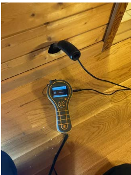
Hulltaking i tilstøtende rom.
