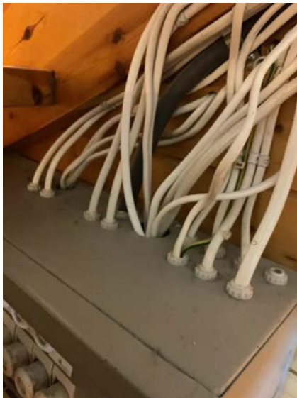
Utette gjennomføringer.
