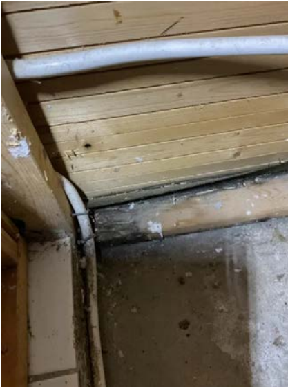
Tidligere fuktskade.
