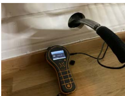
Hulltaking i tilstøtende rom.
