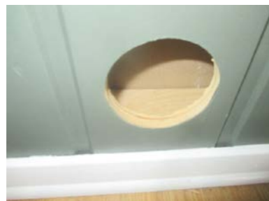
Hulltaking i fra vindfang.
