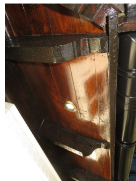
Nedforet gesims med belysning - over inngangsparti.
