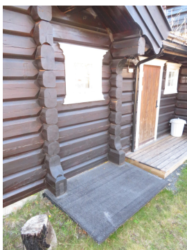
Bilet viser papptekket platting, hvor denne ligger som tildekking over adkomst til del av plate under toalettrommet.
