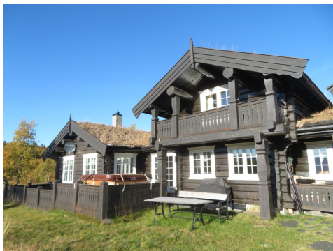
Fasade med overbygde deler ut for spisetue samt balkong i 2.etg - åpen solterrasse med jacuzzi.
