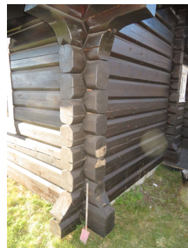
Ytterveggskonstruksjon som viser lafteknuter med etablert synkerom.
