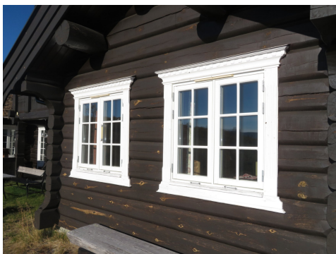
Dels noe slitte overflater på utv. belistning.
