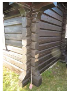
Ytterveggskonstruksjon som viser lafteknuter med etablert synkerom.
