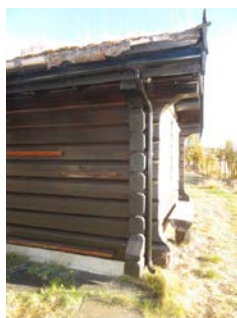
Takrenne med nedløp ført til terreng med utkast.
