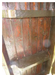
Spaltegesims med fluenetting.
