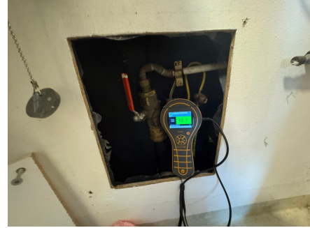
Fuktmåling i inspeksjonsluke ved skyllekar.
