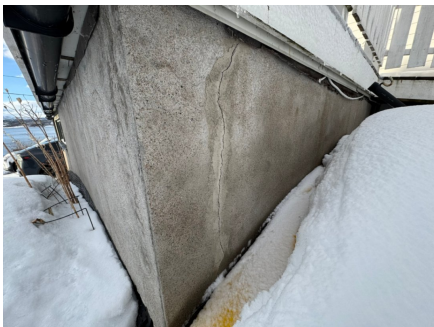
Utbedring av skade som er sprukket opp.
