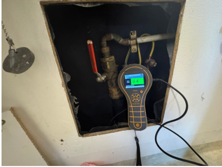
Fuktmåling i inspeksjonsluke ved skyllekar.
