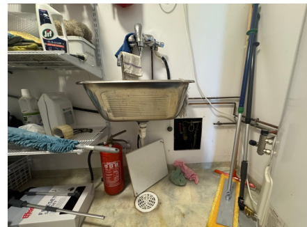
Inspeksjonsluke i våtsonen ved skyllekaret.
