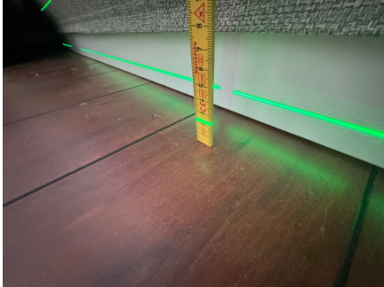
Måling utført på soverommet på loftet.
