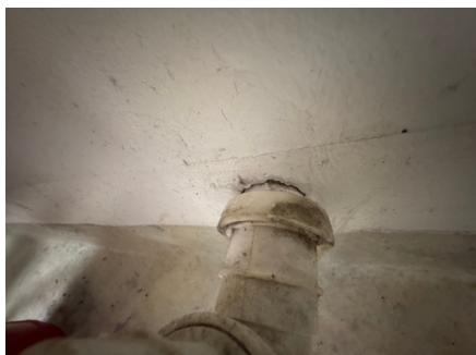
Eksempel på utetthet.
