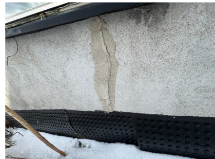
Utbedring av skade som er sprukket opp.
