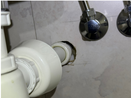
Utett rørgjennomføring.
