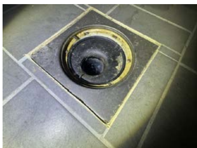
Utett rørgjennomføring.
