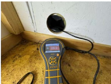
Fuktmåling i vegg fra bod mot terreng.
