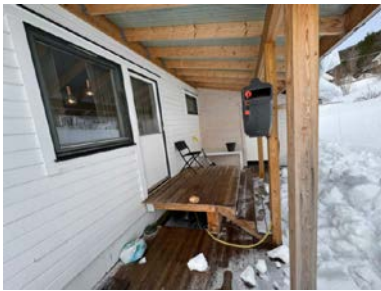
Trapp på baksiden av huset.
