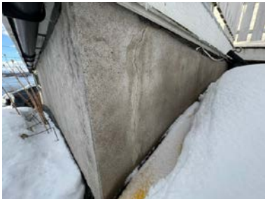
Utbedring av skade som er sprukket opp.
