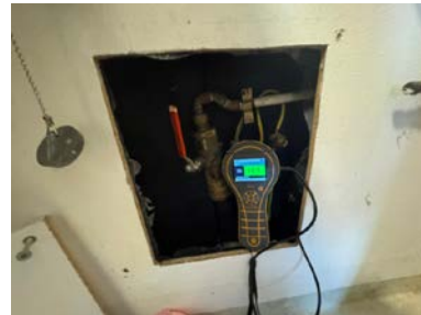
Fuktmåling i inspeksjonsluke ved skyllekar.
