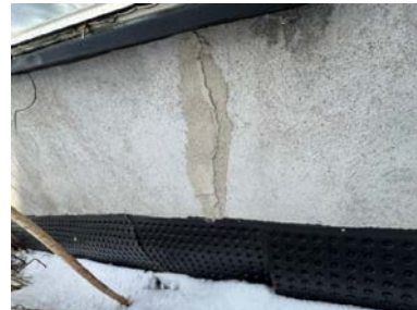
Utbedring av skade som er sprukket opp.
