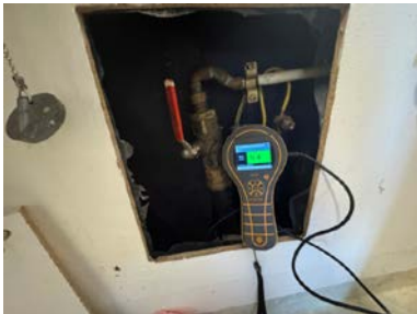
Fuktmåling i inspeksjonsluke ved skyllekar.
