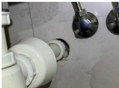
Utett rørgjennomføring.
