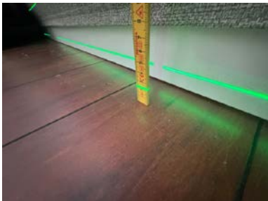
Måling utført på soverommet på loftet.
