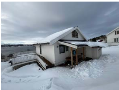
Det er ikke montert snøfangere på takoverbygget på baksiden.
