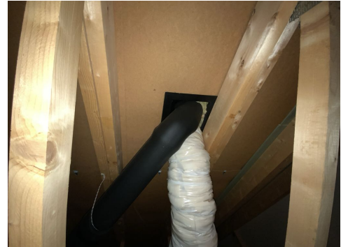
Kontroll rundt rørgjennomføringer.
