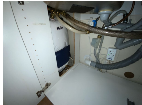
Besiktigelse av bereder.
