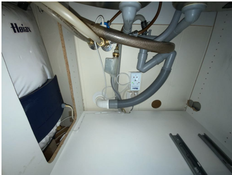
Besiktigelse av røropplegg.
