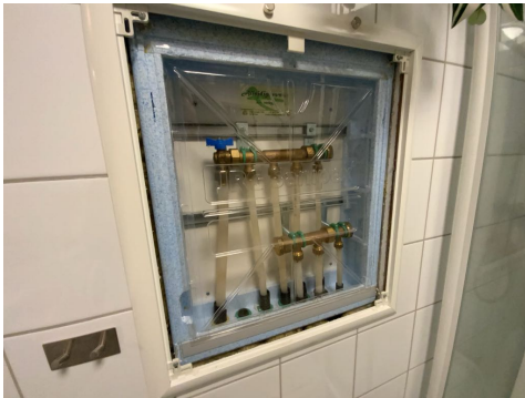
Besiktigelse av røropplegg.
