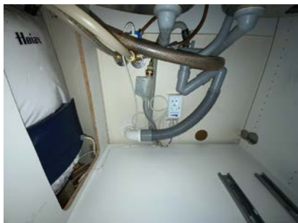
Besiktigelse av røropplegg.
