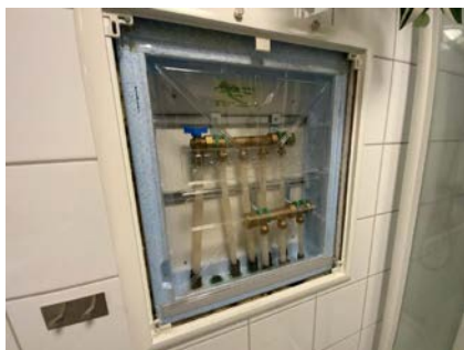
Besiktigelse av røropplegg.
