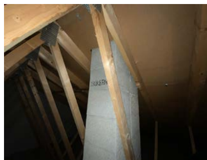
Kontroll rundt pipeløp.
