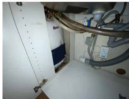
Besiktigelse av bereder.
