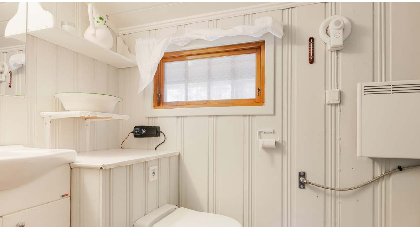
Hygienerommet er også en del av tilbygget fra 2008. Rommet er innredet med benkeskap med servant, speil, hyller, vakuumtoalett, elektrisk vifte i vegg, veggmontert varmtvannsbereider og dusjkabinett.
