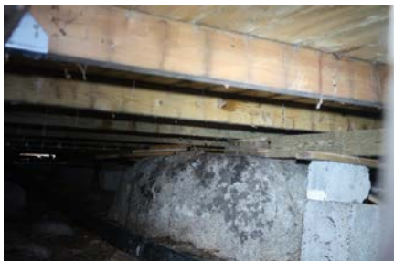
Bilde viser oppretting/ fundamentering av terrasse. Bør kontrolleres ytterligere
