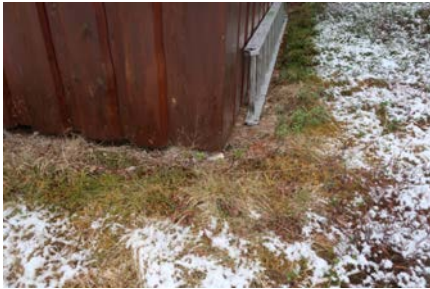
Bilde viser liten avstand mellom terreng og ytterkledning
