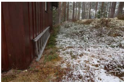
Bilde viser terrengfall inn mot konstruksjon lags nordfasaden
