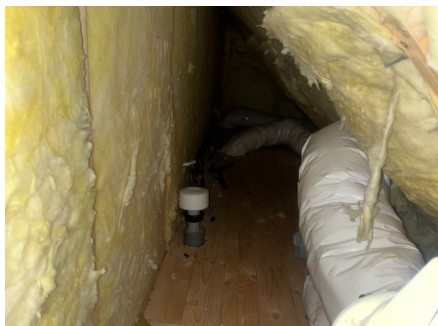
Det er ikke forsegling mellom vannrør og varerør på kor i 2. etasje.
