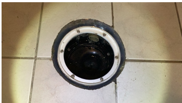
Sluk av plast. Ikke tegn til membran
