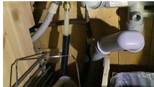
Det er ikke forsegling mellom vannrør og varerør på kjøkken.
