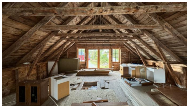
Oversiktsbilde av loft/takkonstruksjon.
