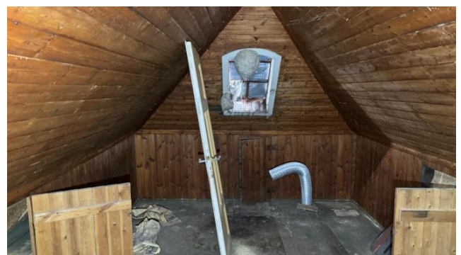
Bilde viser avtrekk som er avsluttet på loft.
